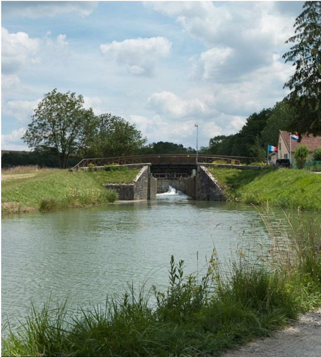
Vue du pont depuis l'aval.
