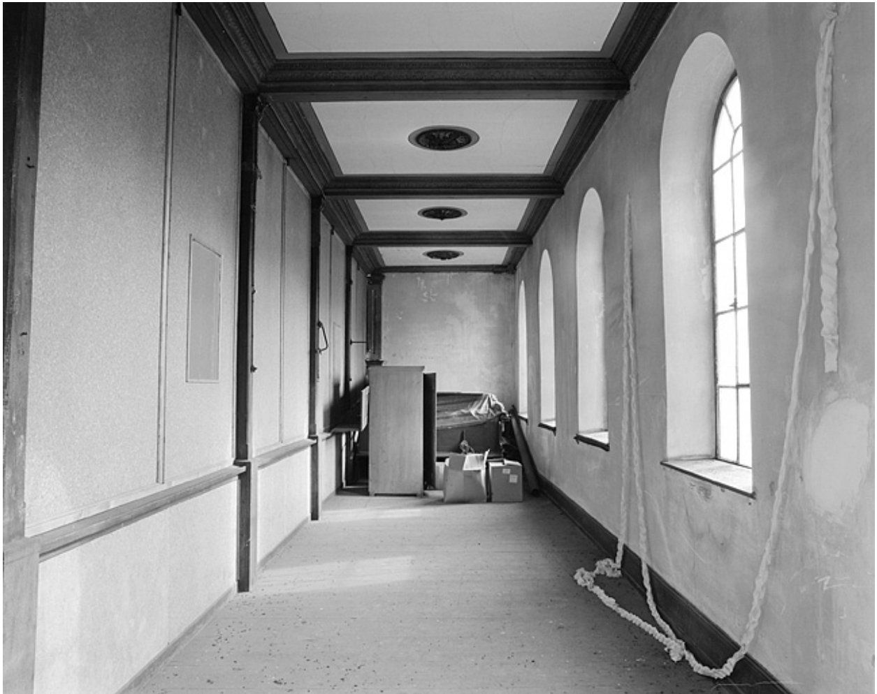
Vue intérieure de la tribune sud.
