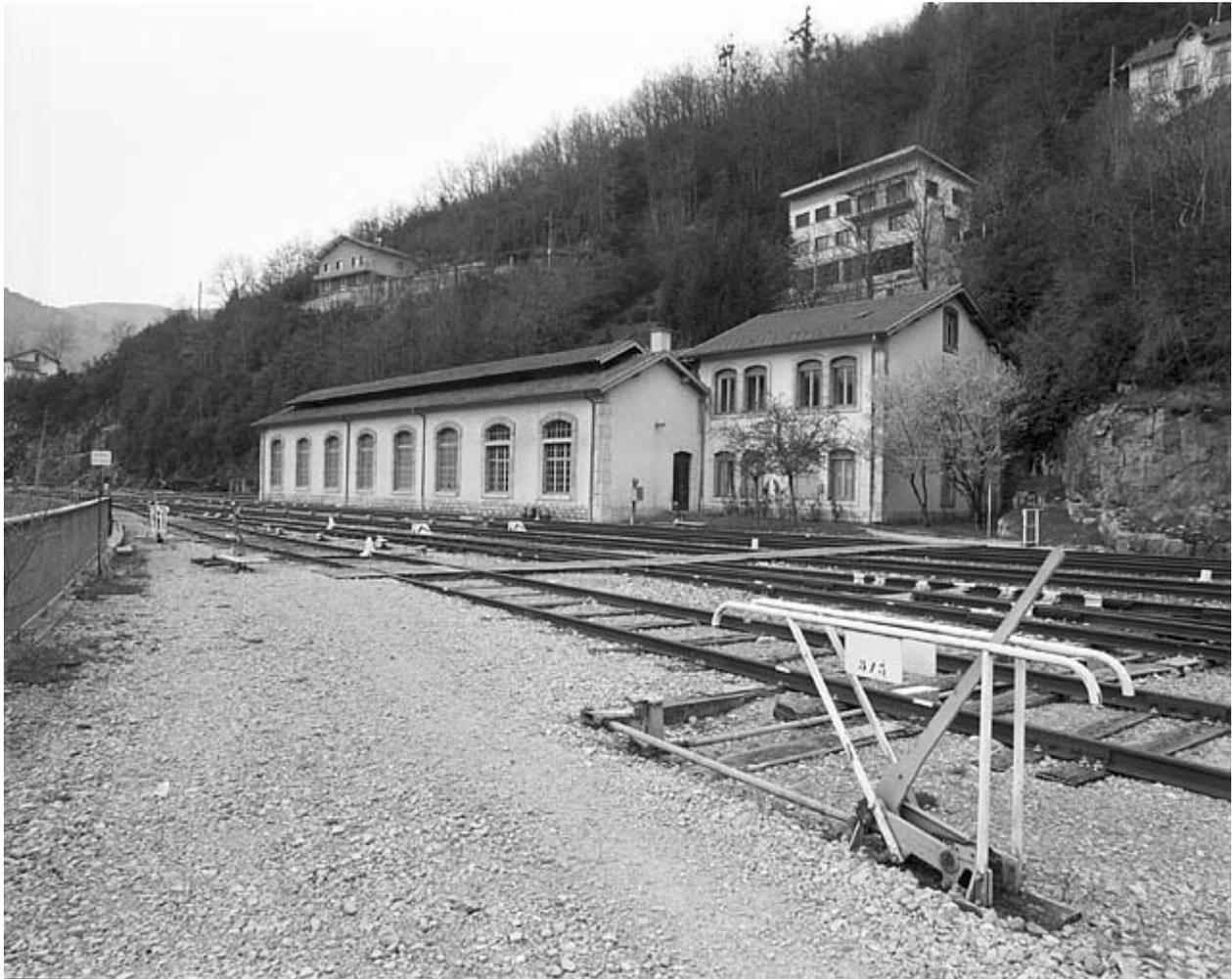
Faisceau des voies vers le foyer des roulants et la remise ferroviaire, depuis le côté Andelot-en-Montagne. Au premier plan, sur le levier de manoeuvre non enclenché, la plaque donne le numéro des voies desservies par l'appareil.
