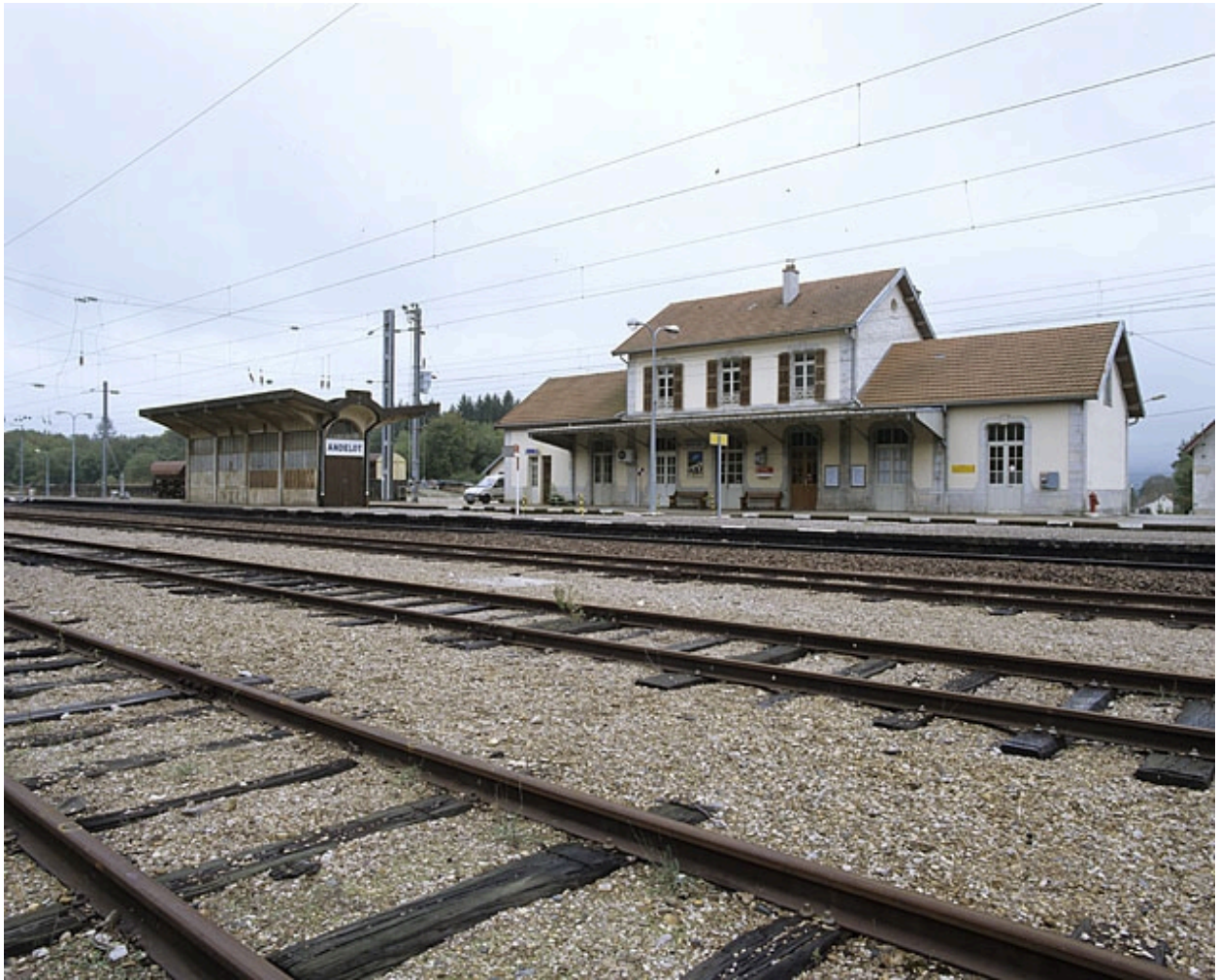
Bâtiment des voyageurs et abri, depuis le nord-ouest.
