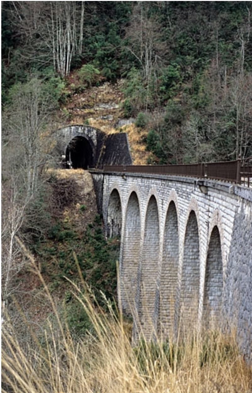
Viaduc : élévation aval, vue en enfilade depuis le côté Andelot-en-Montagne.
