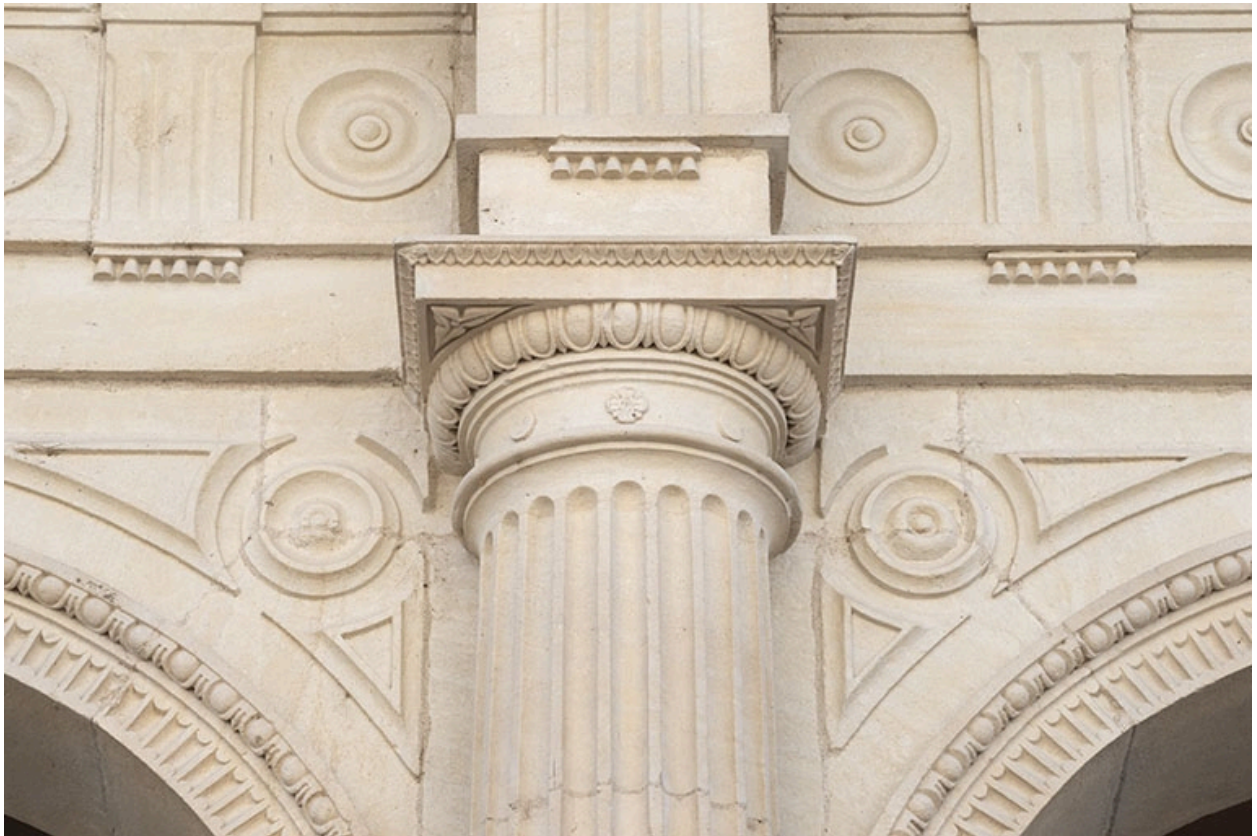
Façade antérieure, rez-de-chaussée : chapiteau dorique.
