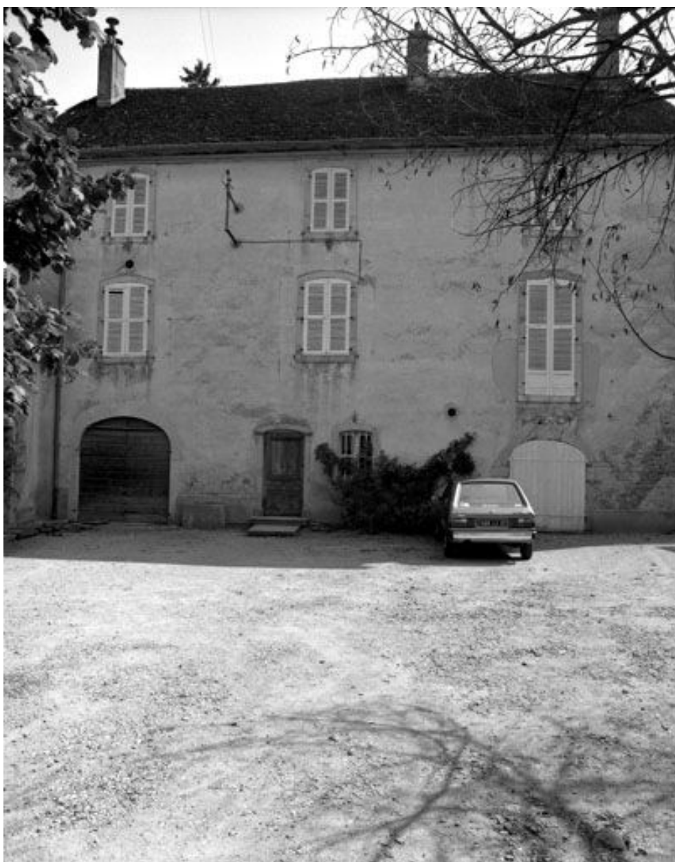
Elévation sur cour.
