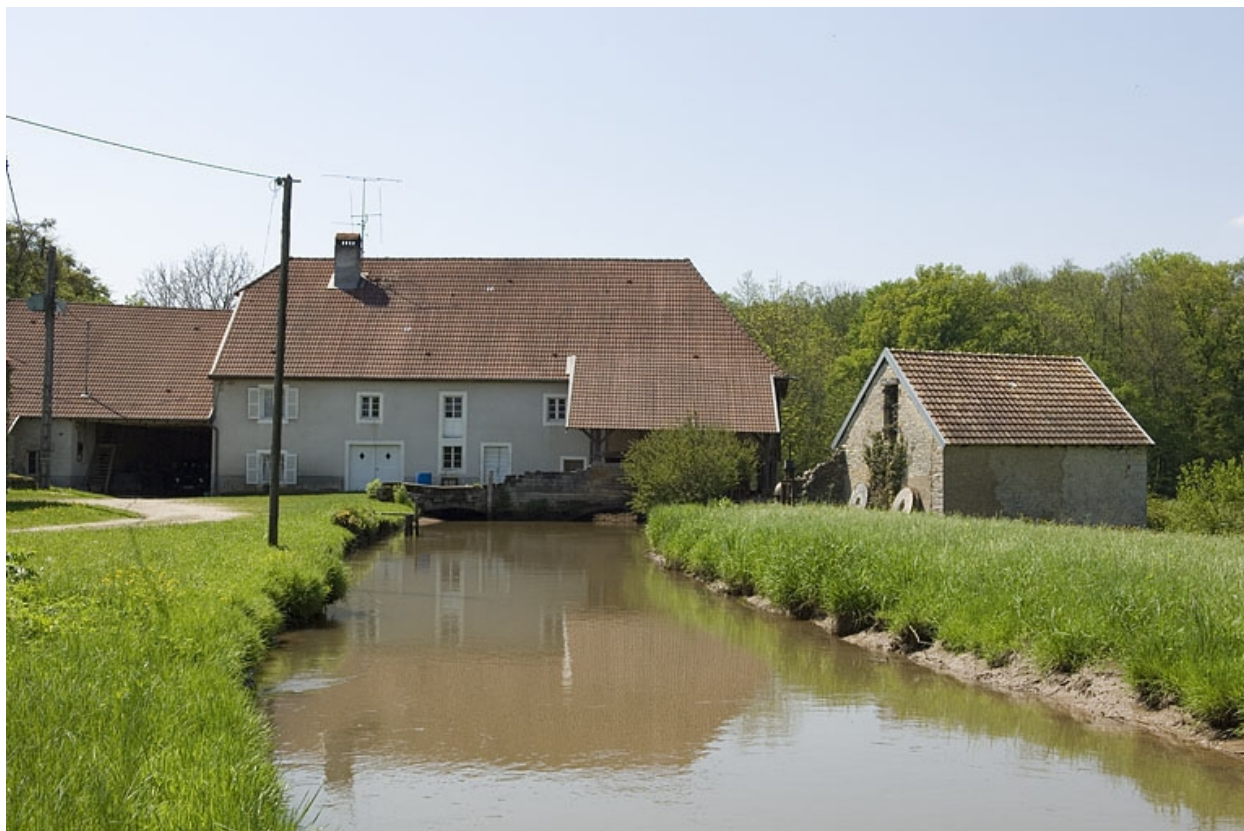
Vue d'ensemble depuis l'amont du bief.
