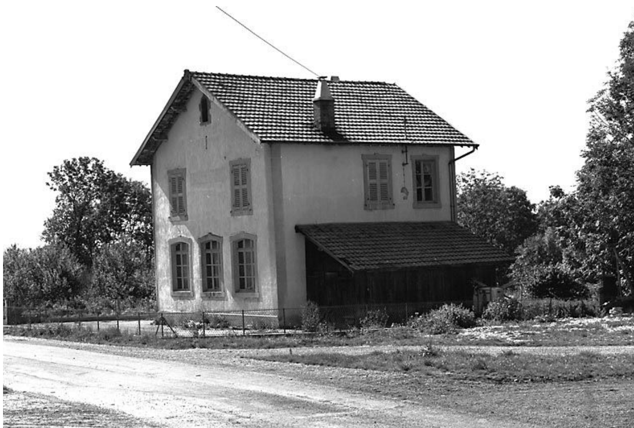
Ecole située 8 chemin du Sel.
