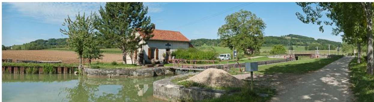
Vue d'ensemble du site d'écluse.
