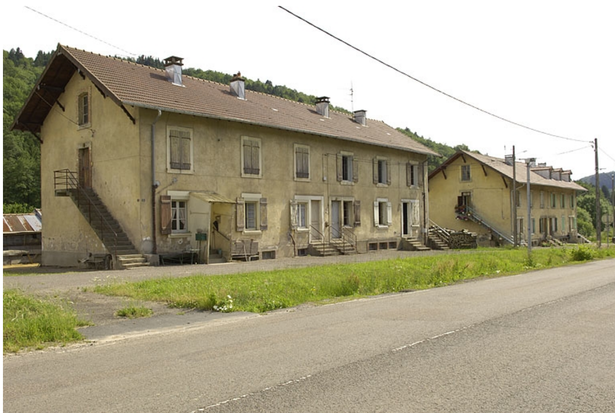
Logements ouvriers depuis le nord-est.
