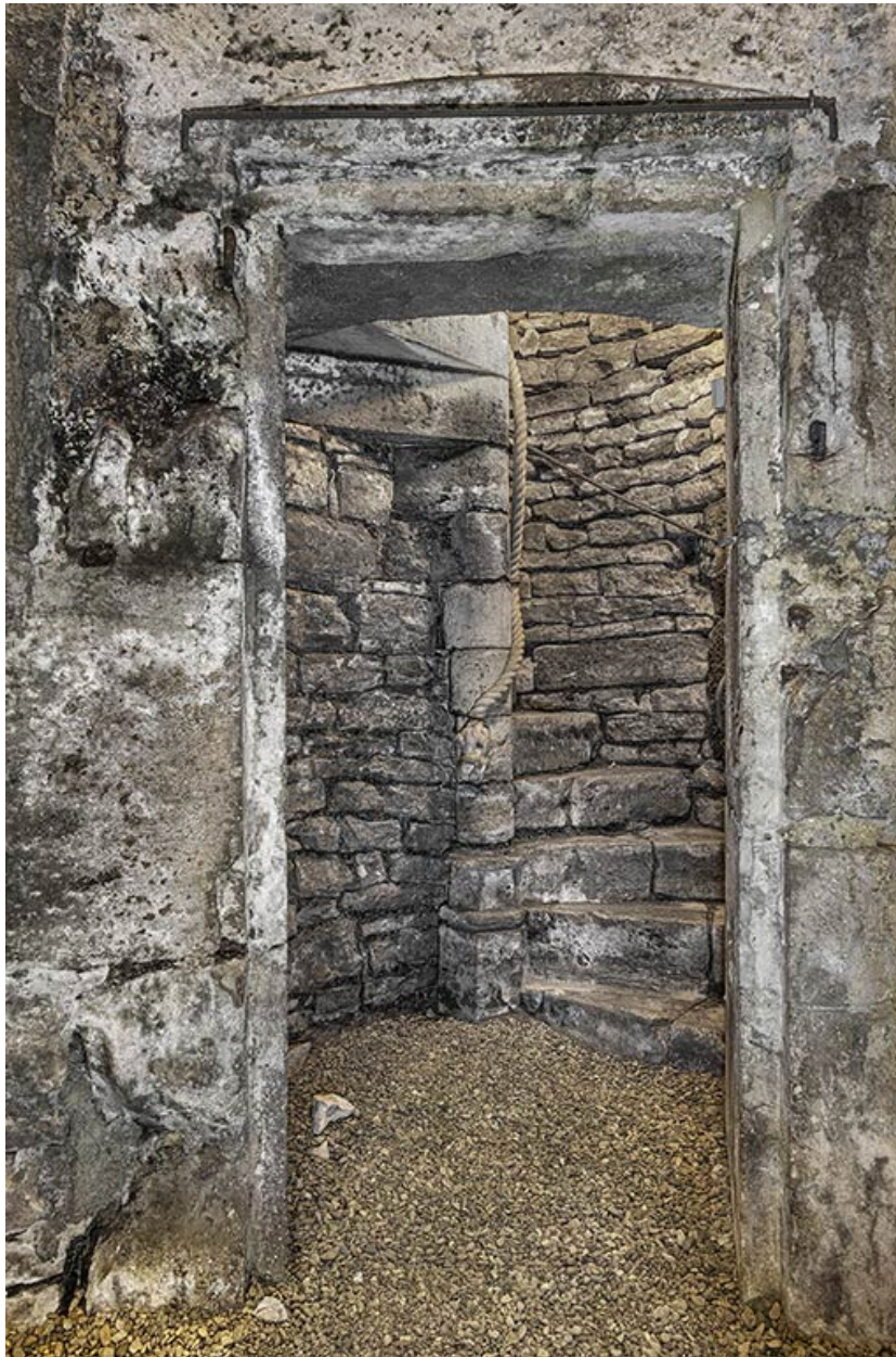
Première volée de l'escalier en vis.
