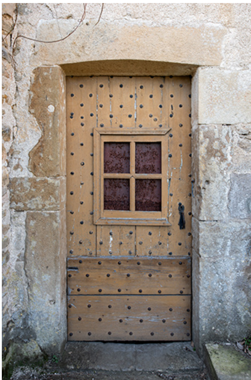
Porte d'accès au couloir du rez-de-chaussée, vue depuis le jardin.
