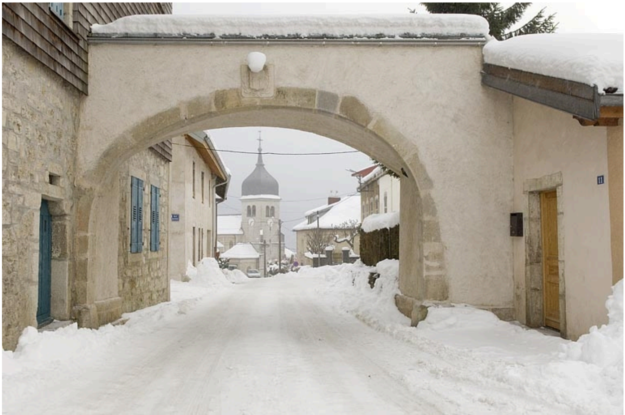
Vue rapprochée de la porte nord, côté faubourg.
