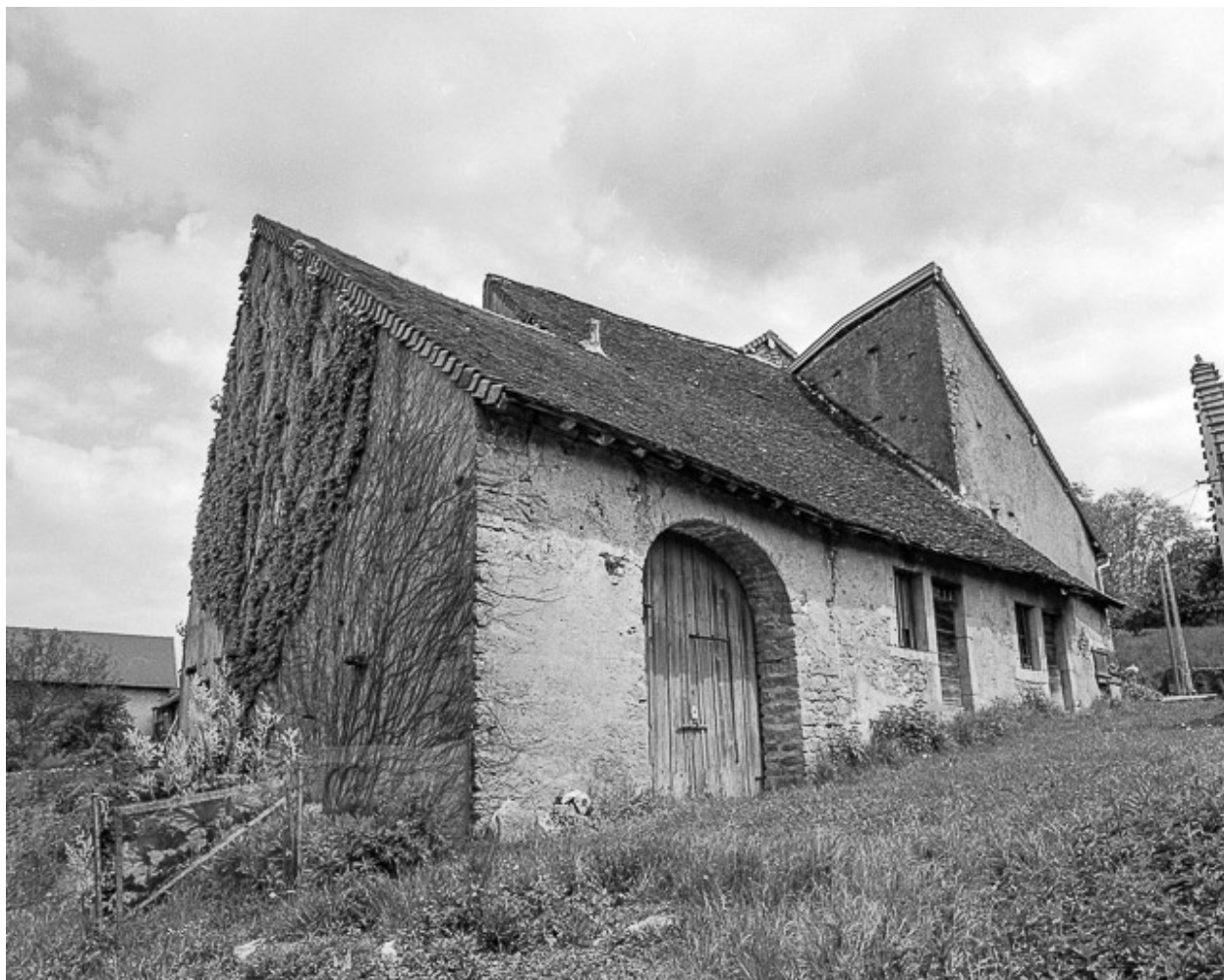
Ferme située rue Chateraine.
