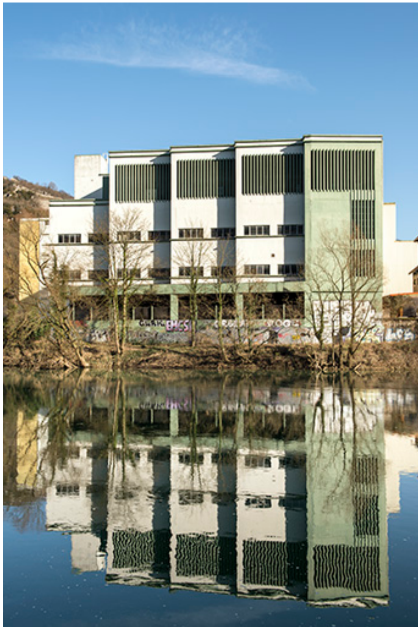
Etat en 2016. Usine B : façade sur le Doubs des ateliers d'étirage tergal et d'ourdissage.
