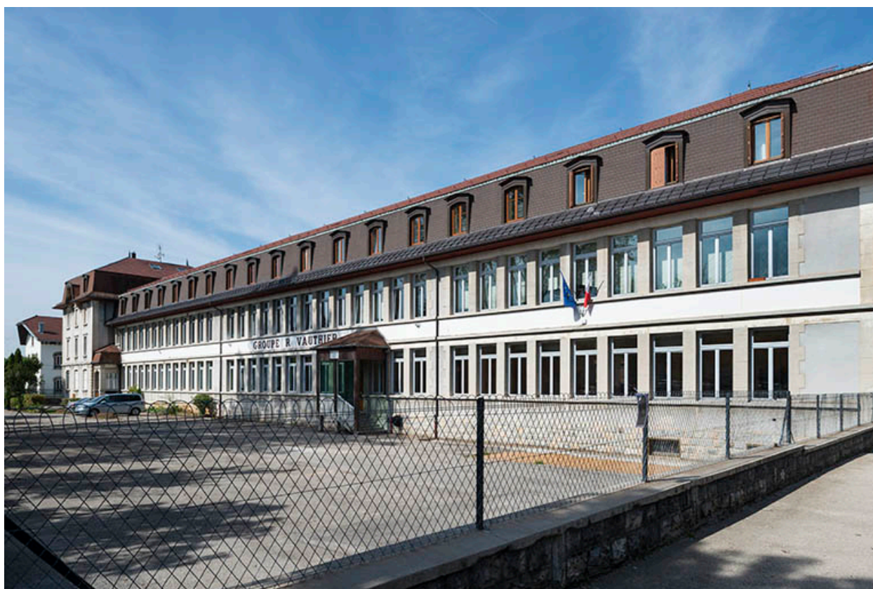
Façade sud vue de trois quarts droite.
