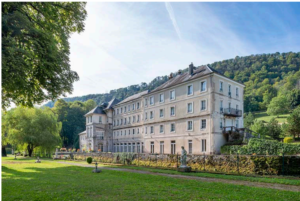
Parc, vue du nord-ouest en direction de l'ancien établissement thermal.
