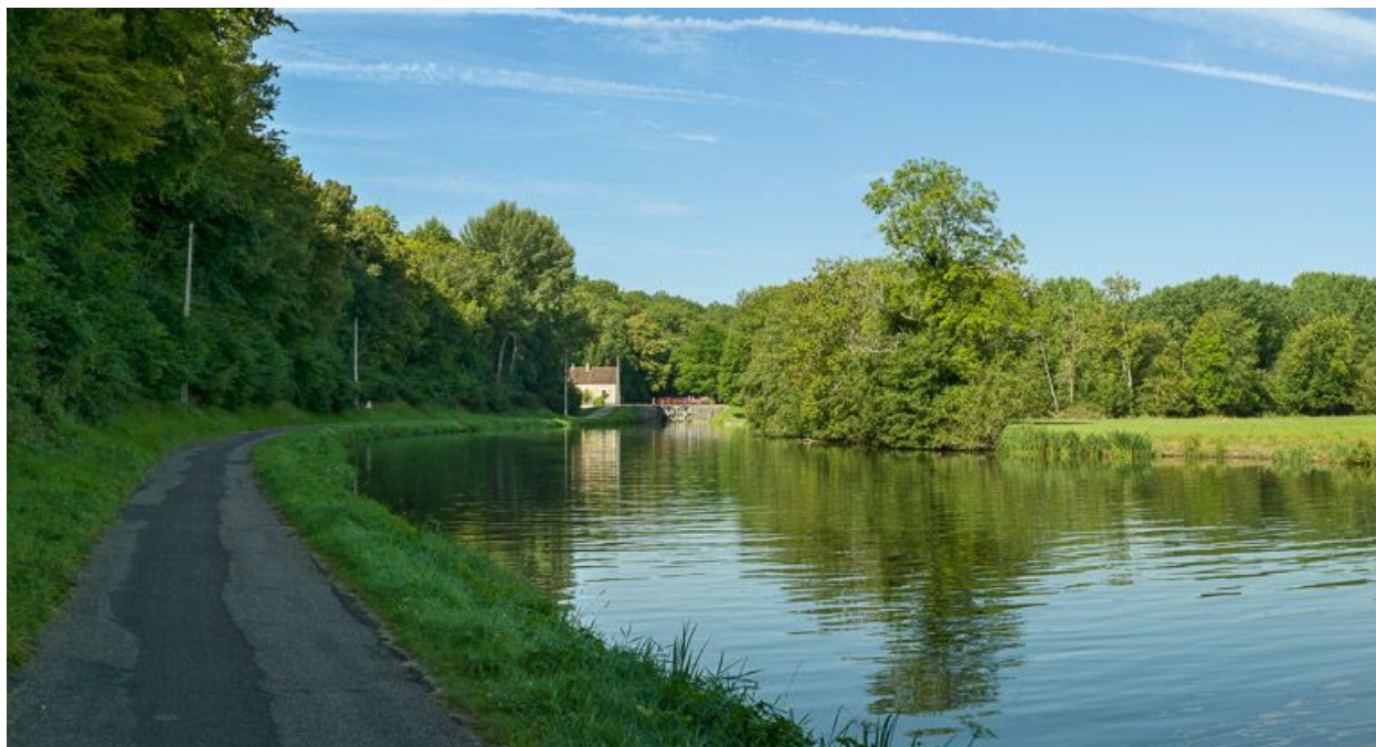
Vue d'ensemble du site pris d'aval.
