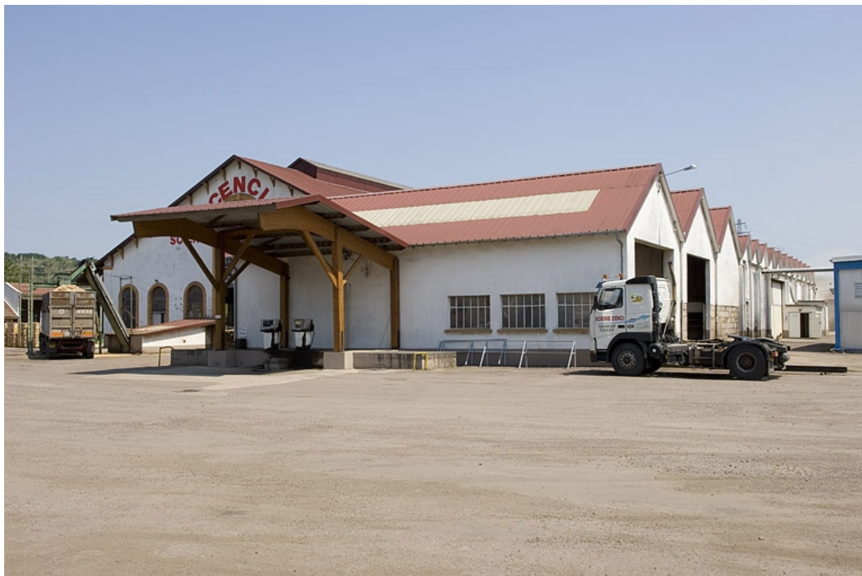
Ateliers de fabrication vus depuis le sud-ouest.
