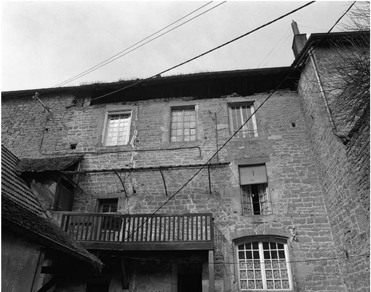
Maison 20 rue Saint-Laurent : élévation sur cour : 2e et 3e niveaux.
