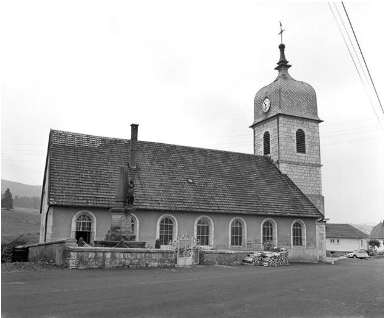
Façade latérale gauche.
