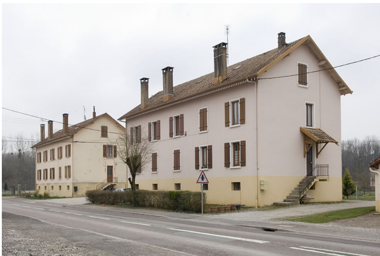
Maisons ouvrières vues de trois quarts.
