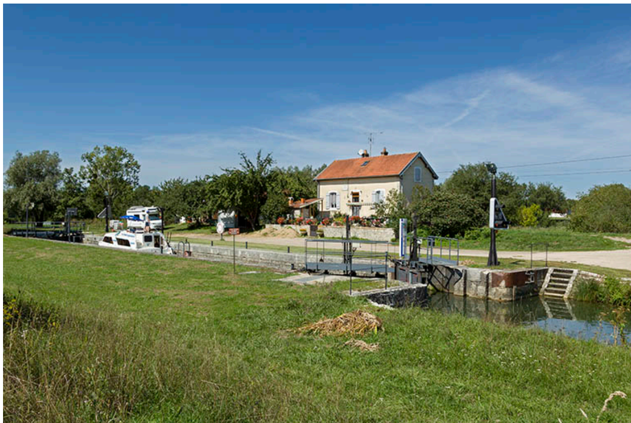
Maison du site d'écluse à Rigny (70).
