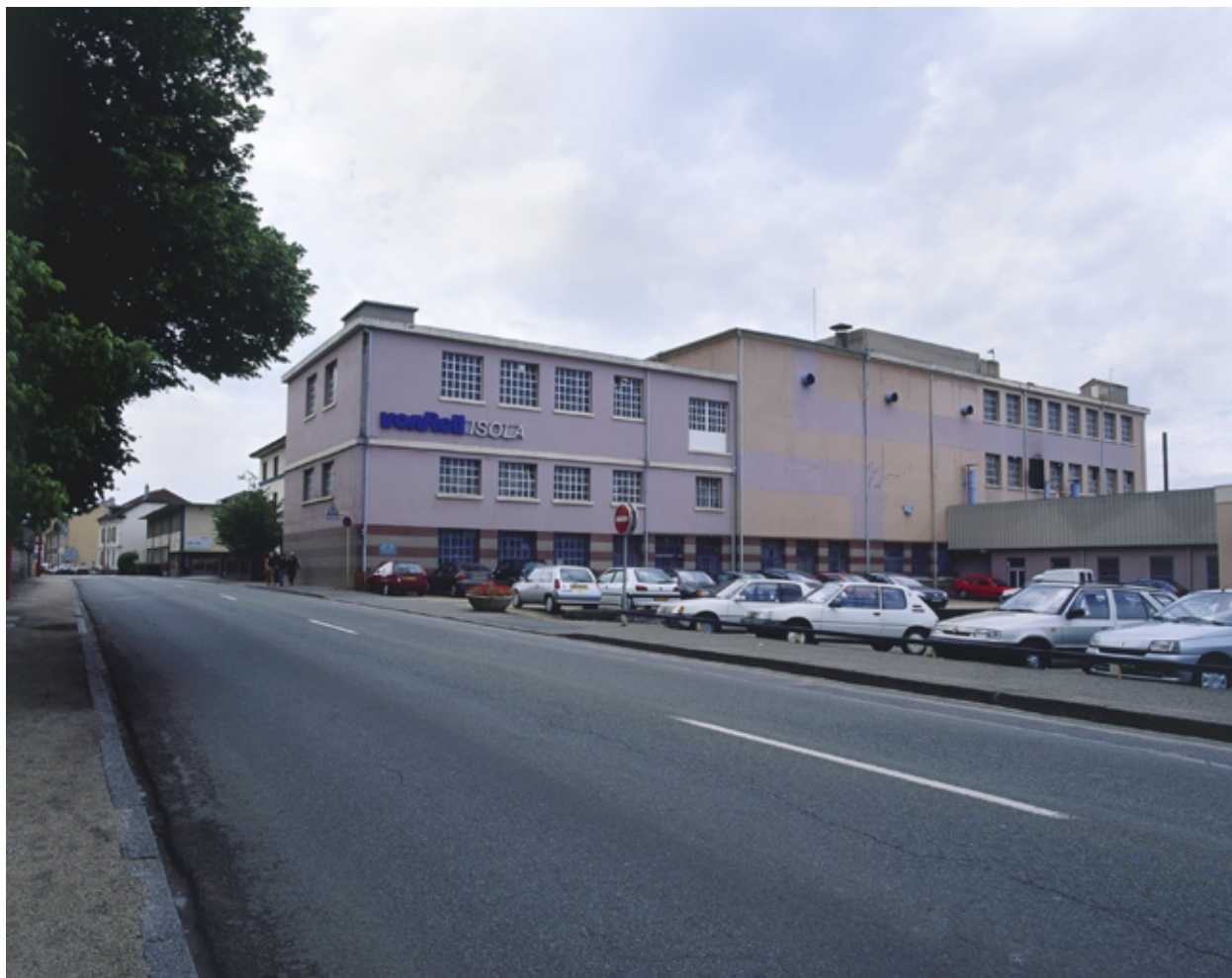
Atelier d'enduction verticale depuis le nord.
