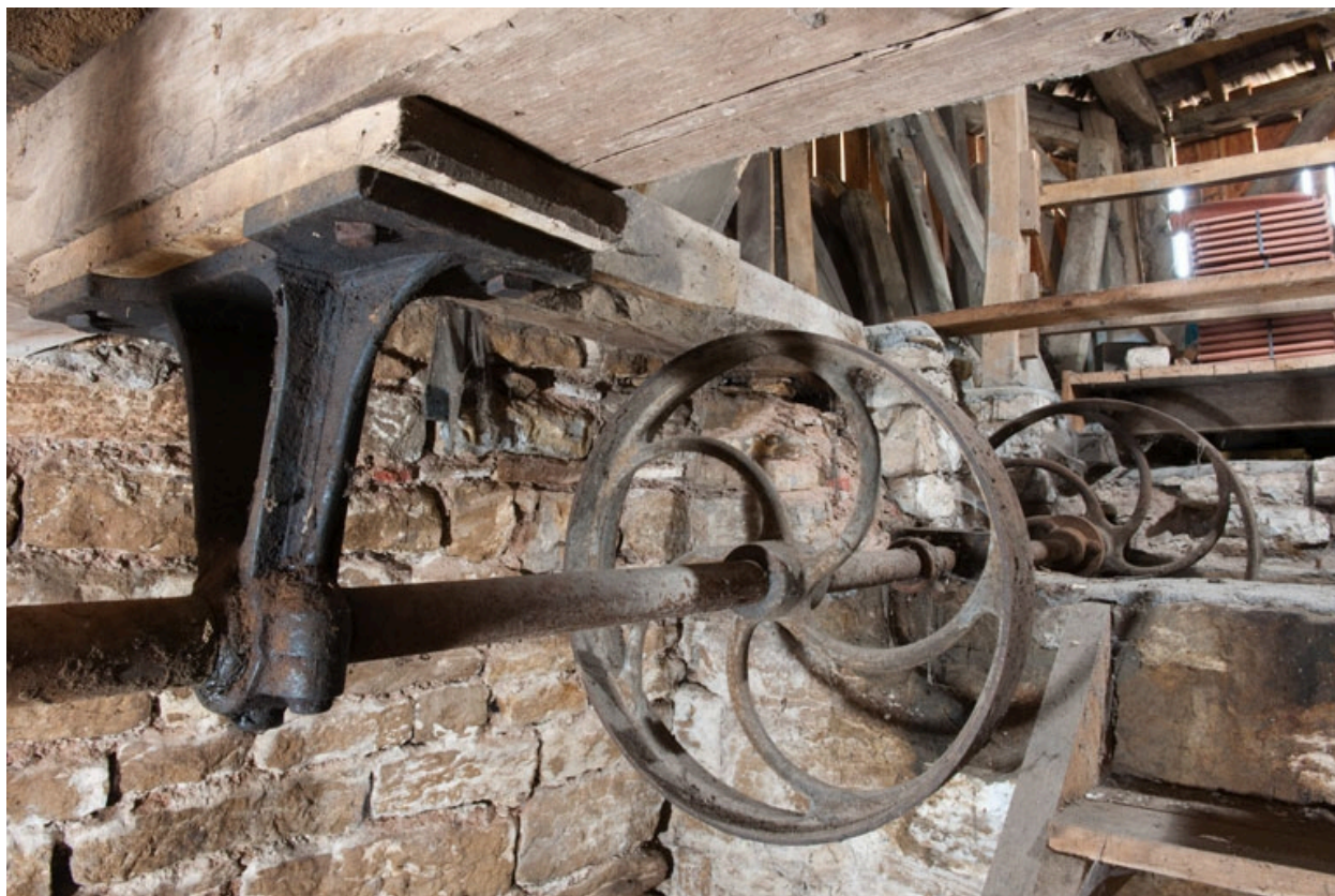
Scierie Courtot, rue du Pont : arbre de transmission.
