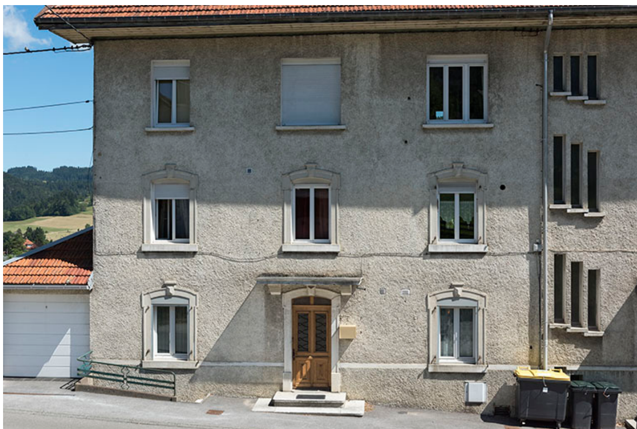
Façade antérieure : partie gauche.
