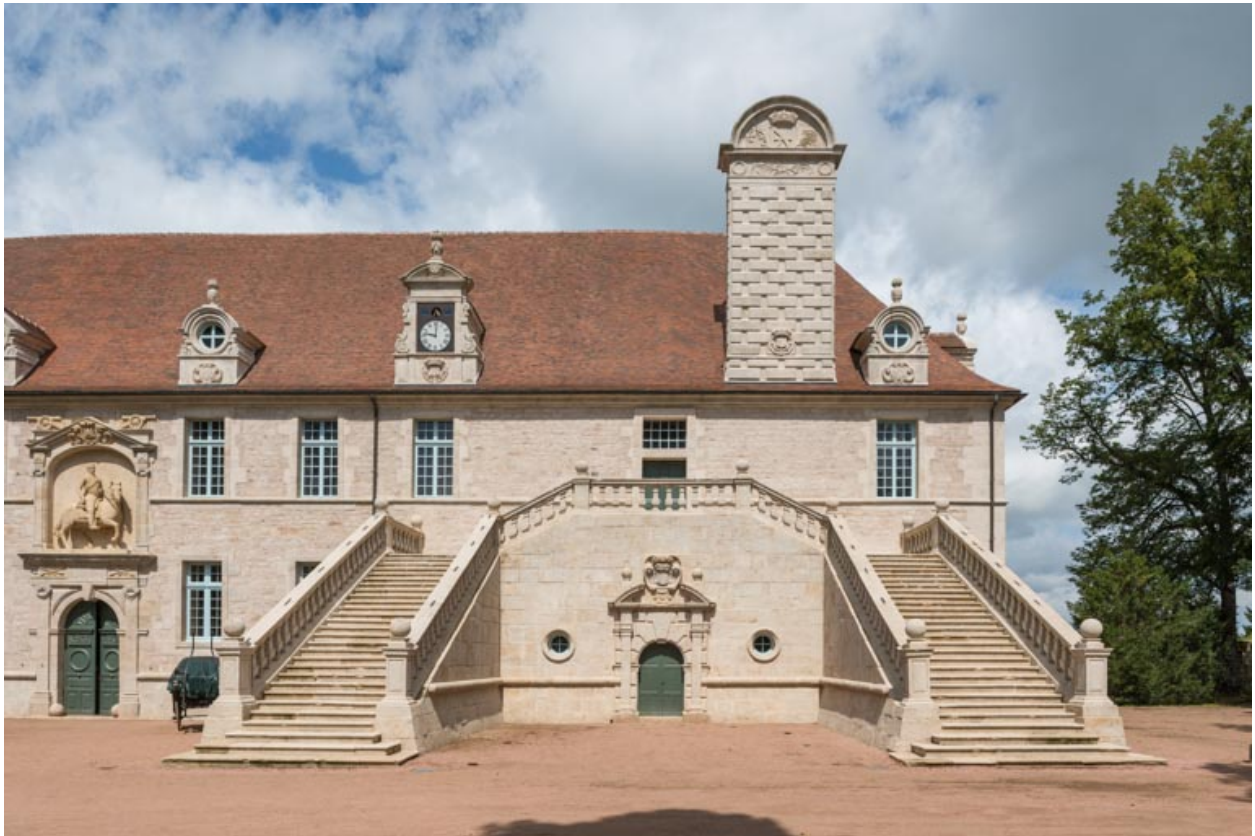
Façade sud-est, partie droite, grand-degré.
