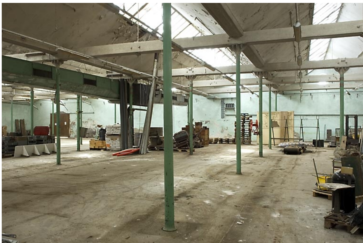
Atelier de fabrication de l'ancienne filature. Travées délimitées par des colonnes de fonte et couvertes de sheds.
