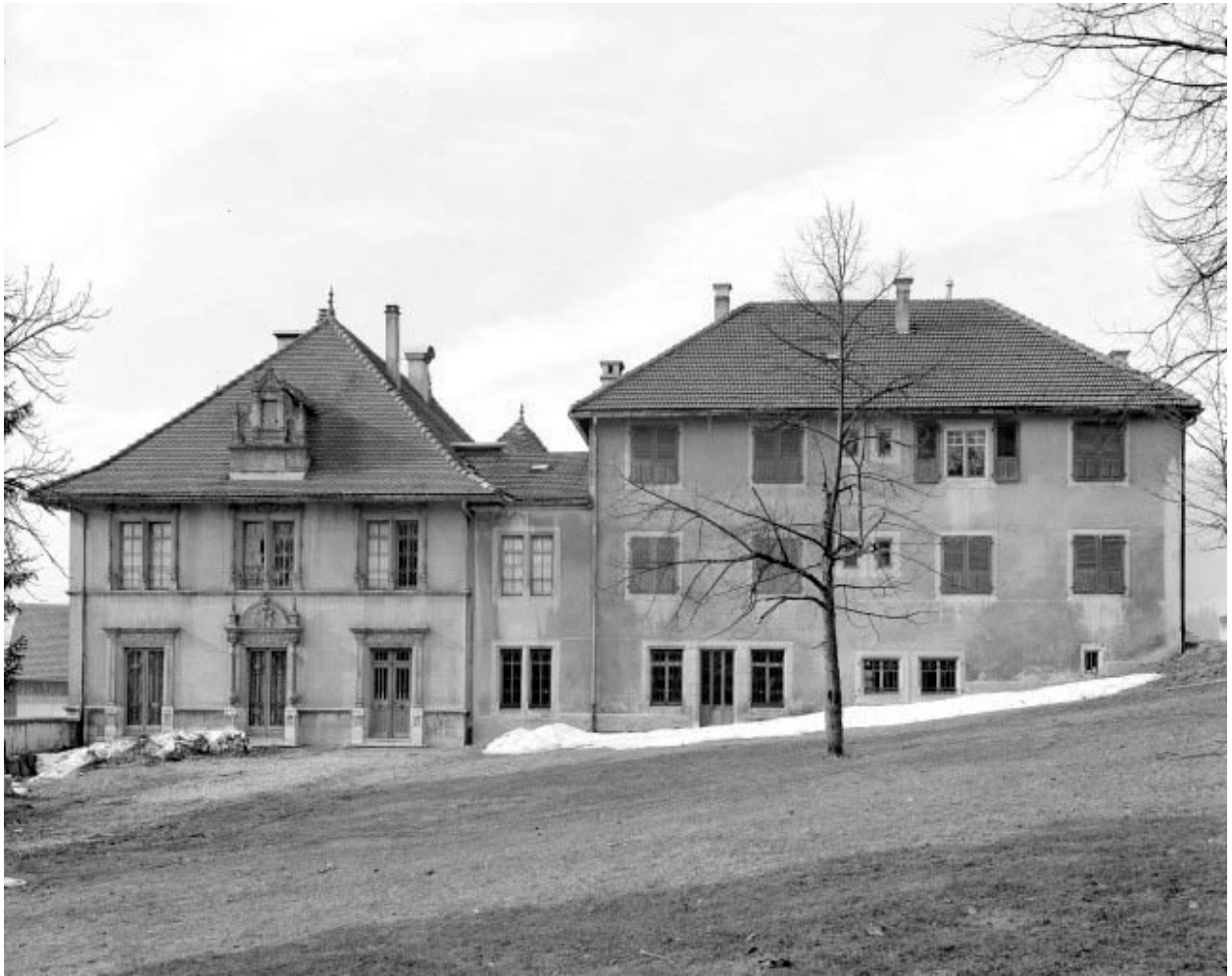
Façade sud est : vue d'ensemble.
