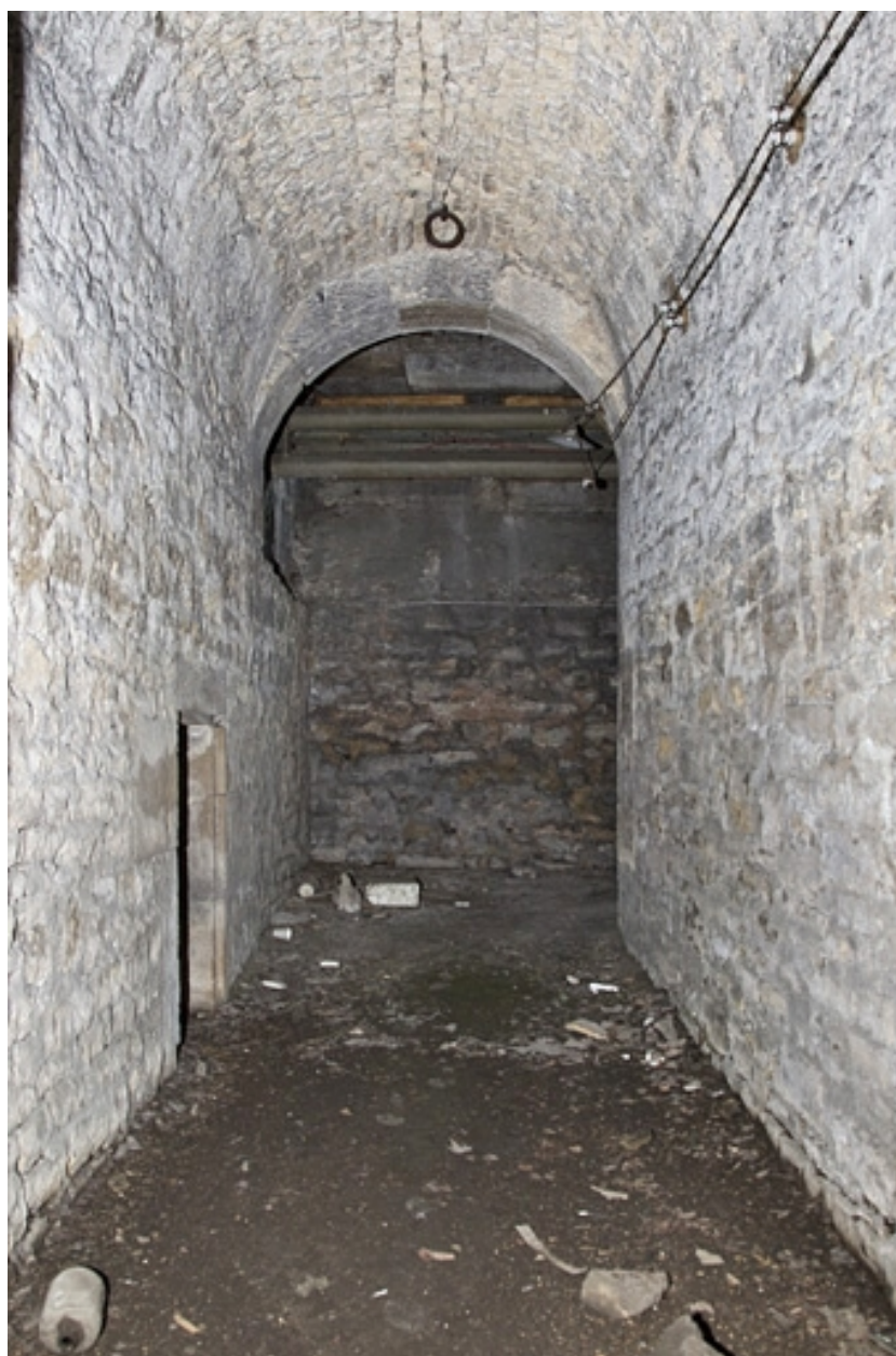
Sous-sol : détail d'un couloir voûté en berceau.
