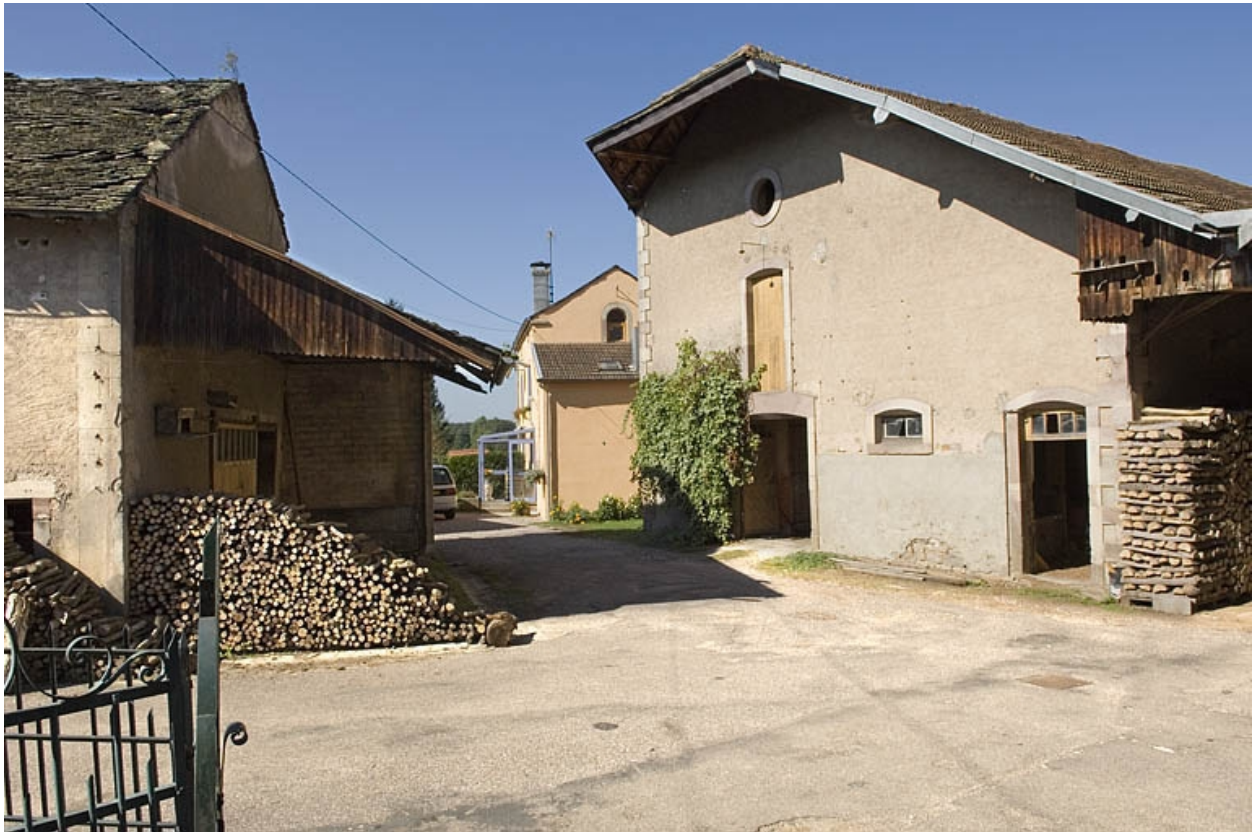
Bâtiments industriels. Vue depuis le logement patronal.
