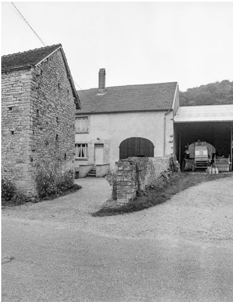
Façade sur cour.
