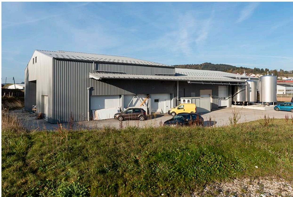
Façade latérale gauche, de trois quarts gauche.
