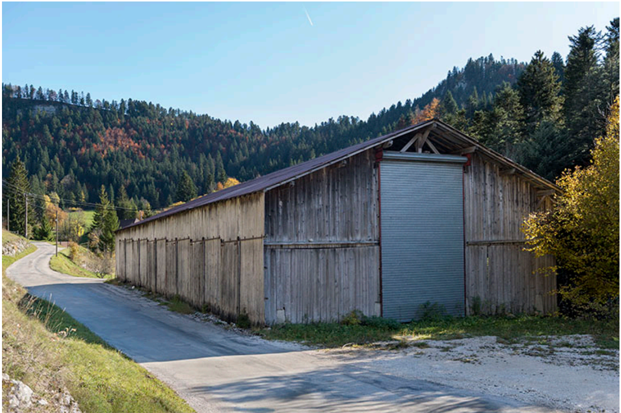
Hangar, au nord.
