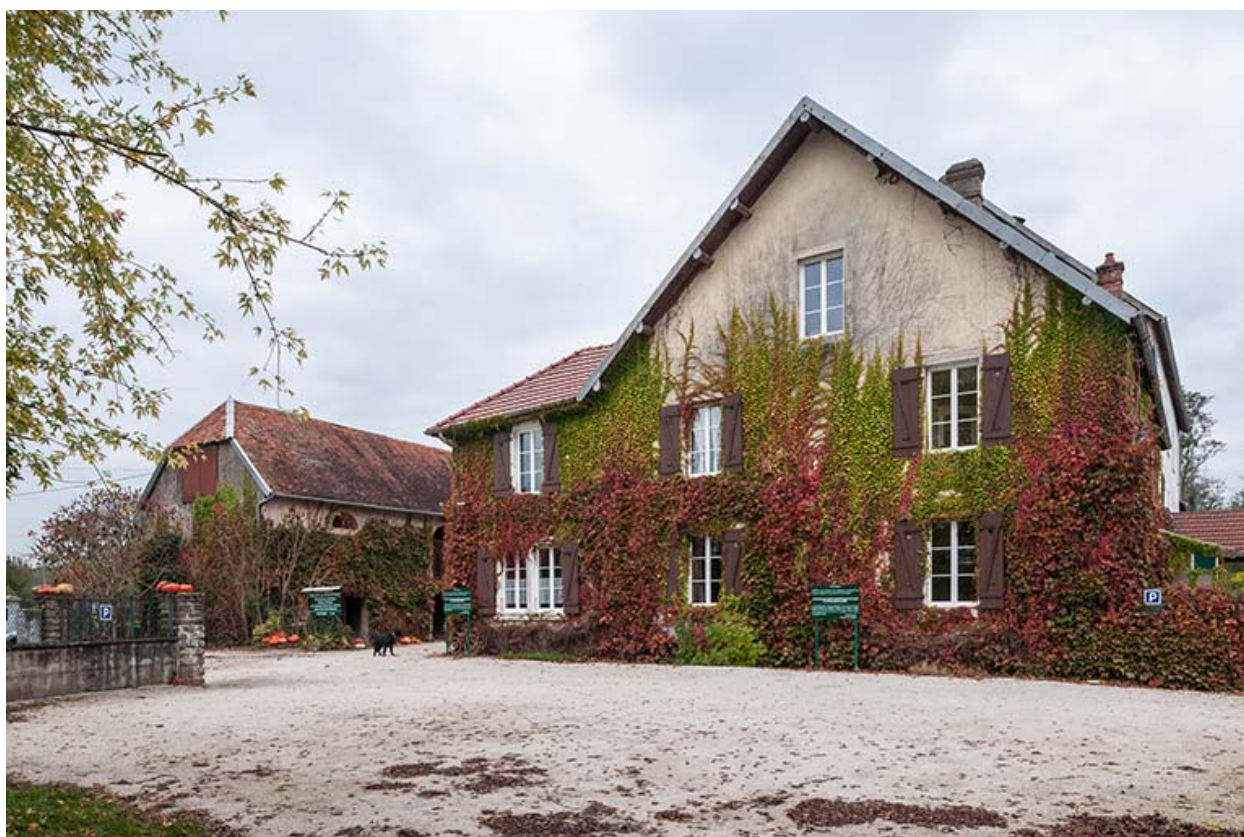
Le bâtiment à fonction agricole et le logement.
