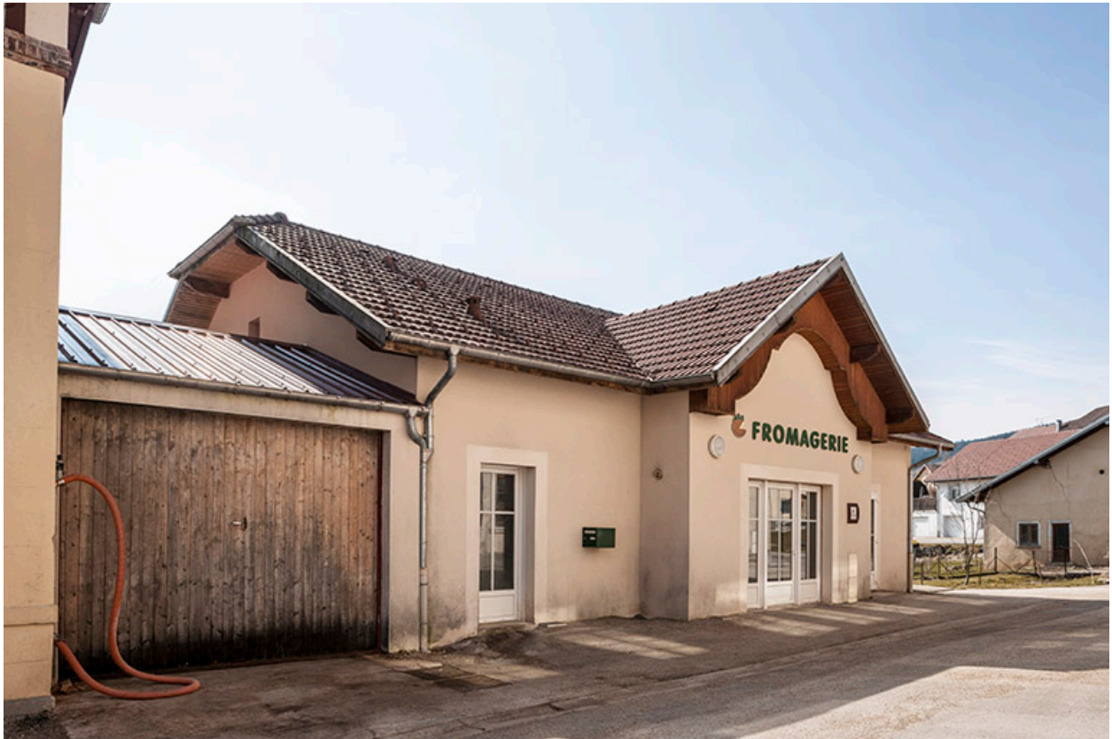
Nouvelle fromagerie vue de trois quarts gauche.
