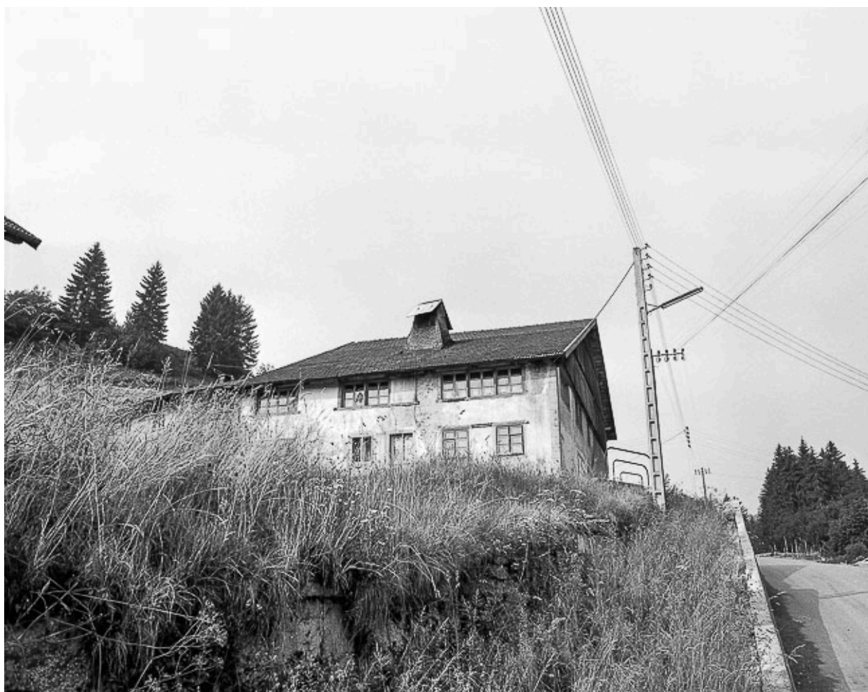
Ferme située 3 rue du Moulin : façades antérieure et latérale gauche
