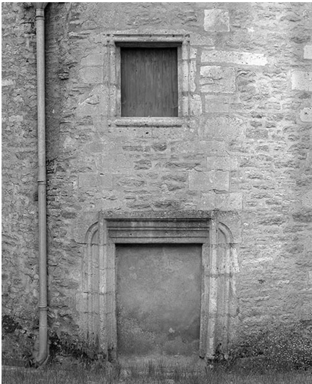
Porte et fenêtre de la tourelle d'escalier.
