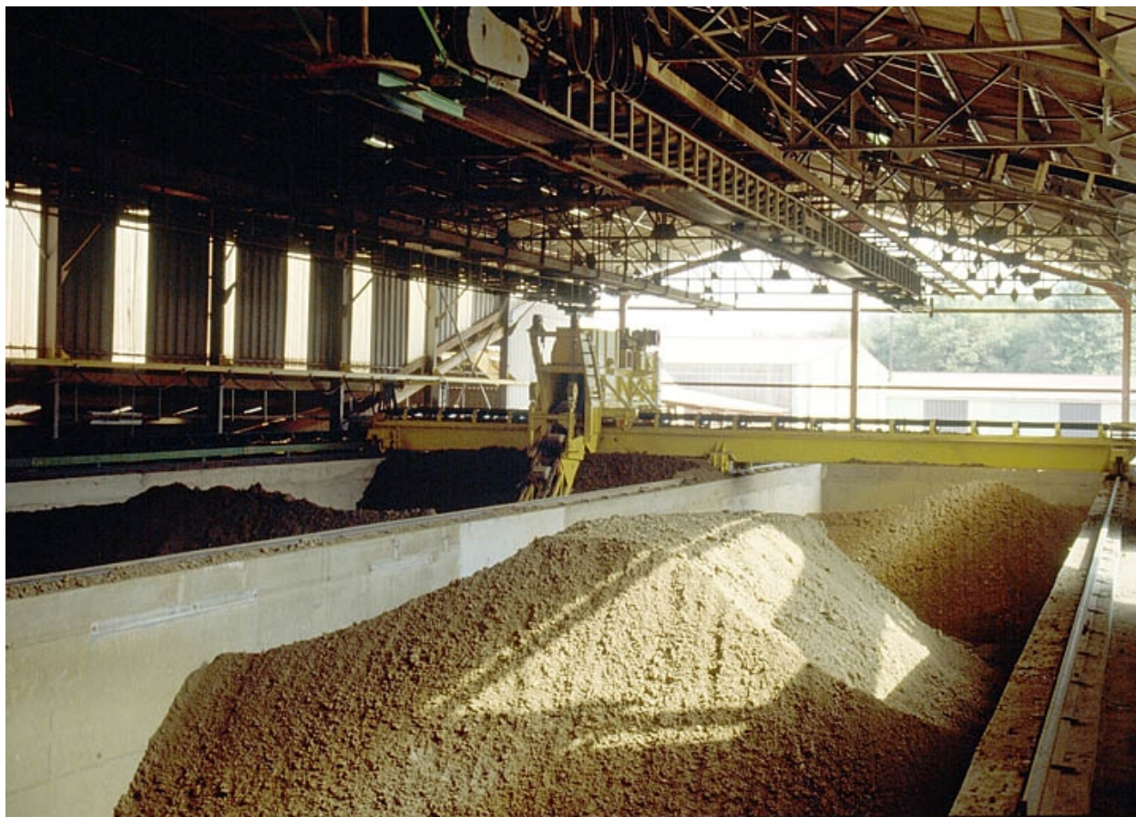
Intérieur du hangar à terre (I).
