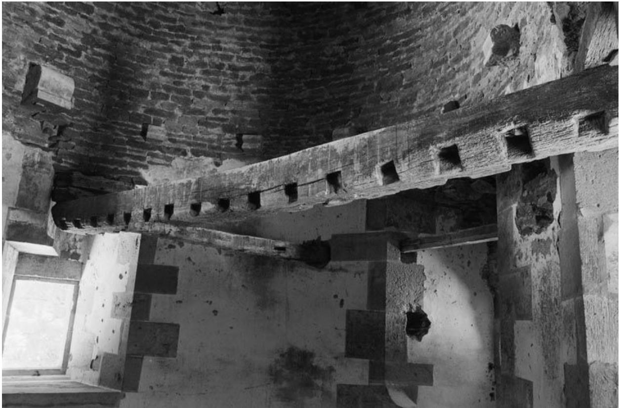
Charpente de la tour d'entrée, détail (photo prise en 1969).
