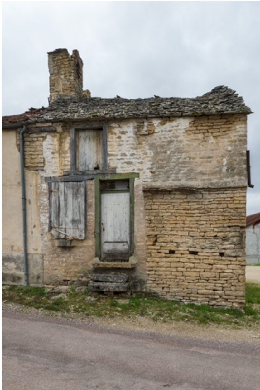
Vue de la façade ouest.
