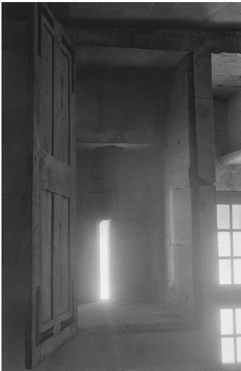
Appartement : latrines (photo prise en 1969).
