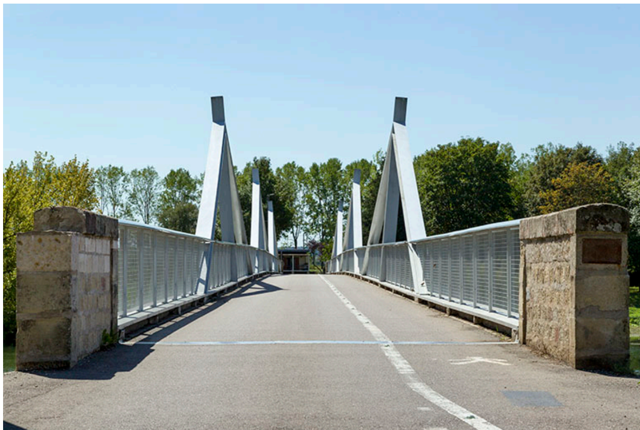
Pont de Rigny.
