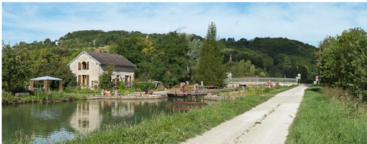
Vue du site d'écluse depuis l'amont.
