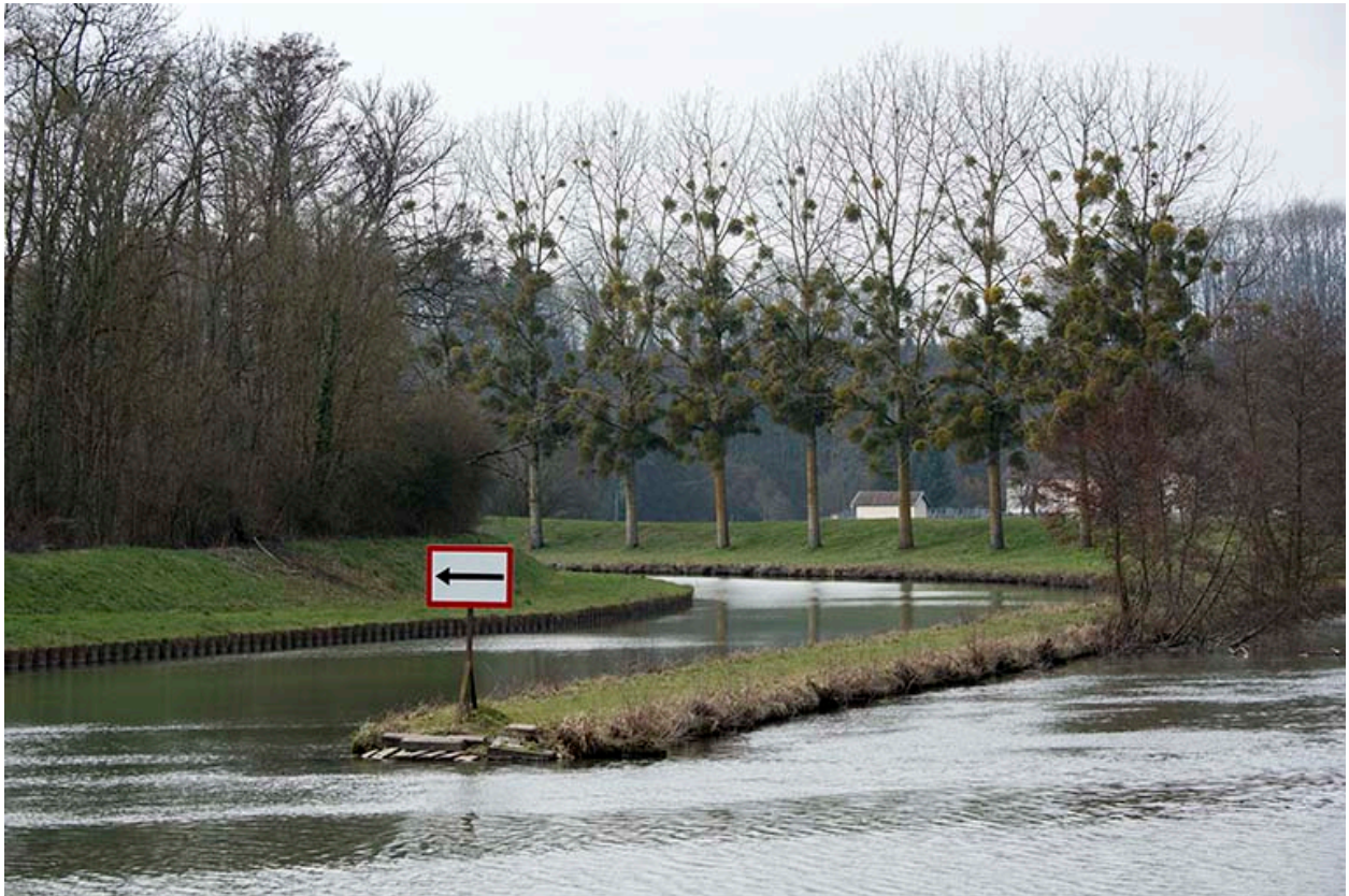
Entrée du canal de navigation d'Ormoy.
