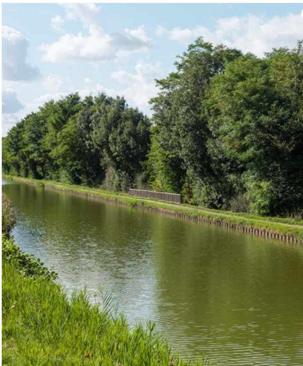
Vue de l'aqueduc-déversoir.
