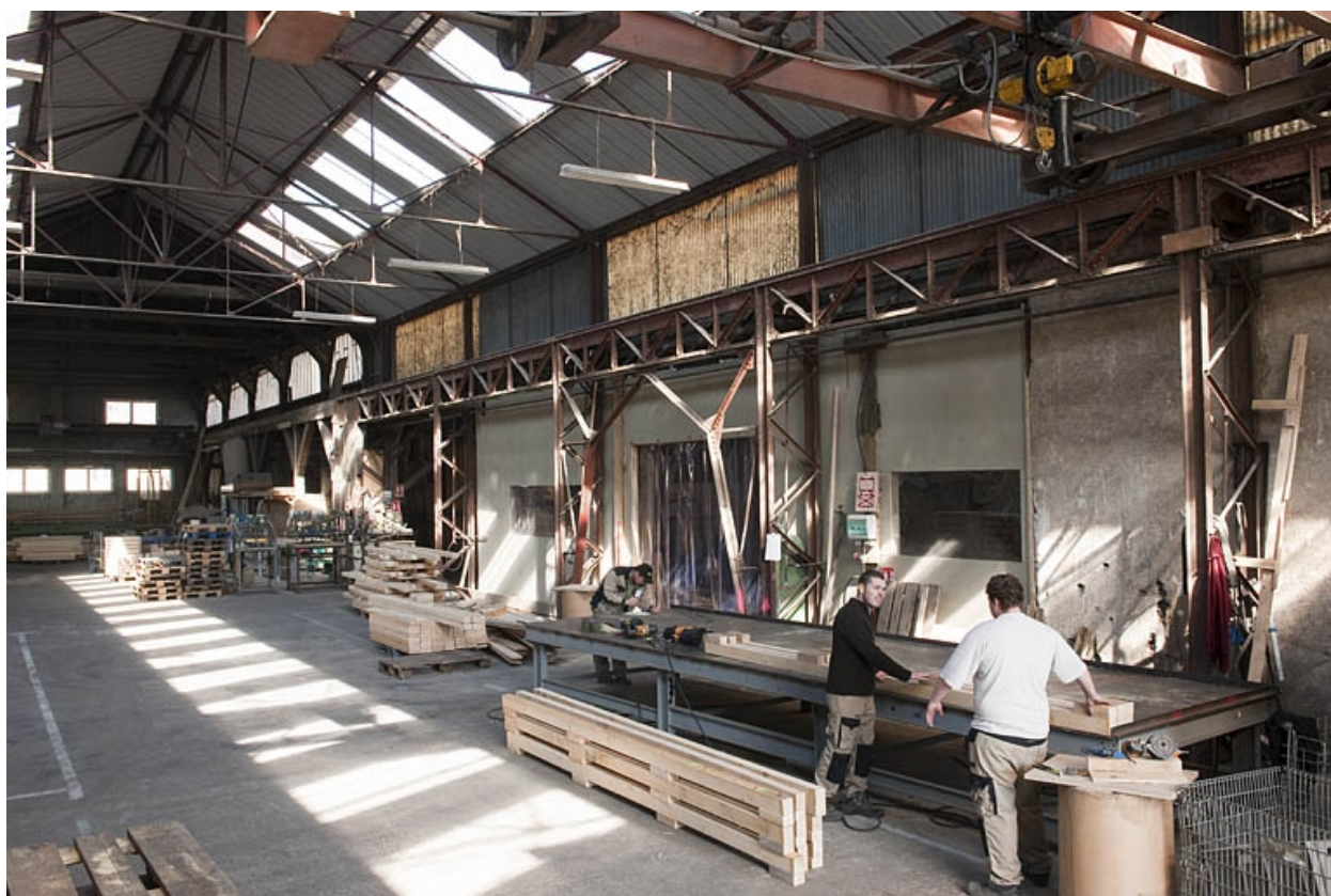
Halle de fonderie. Vue d'ensemble.
