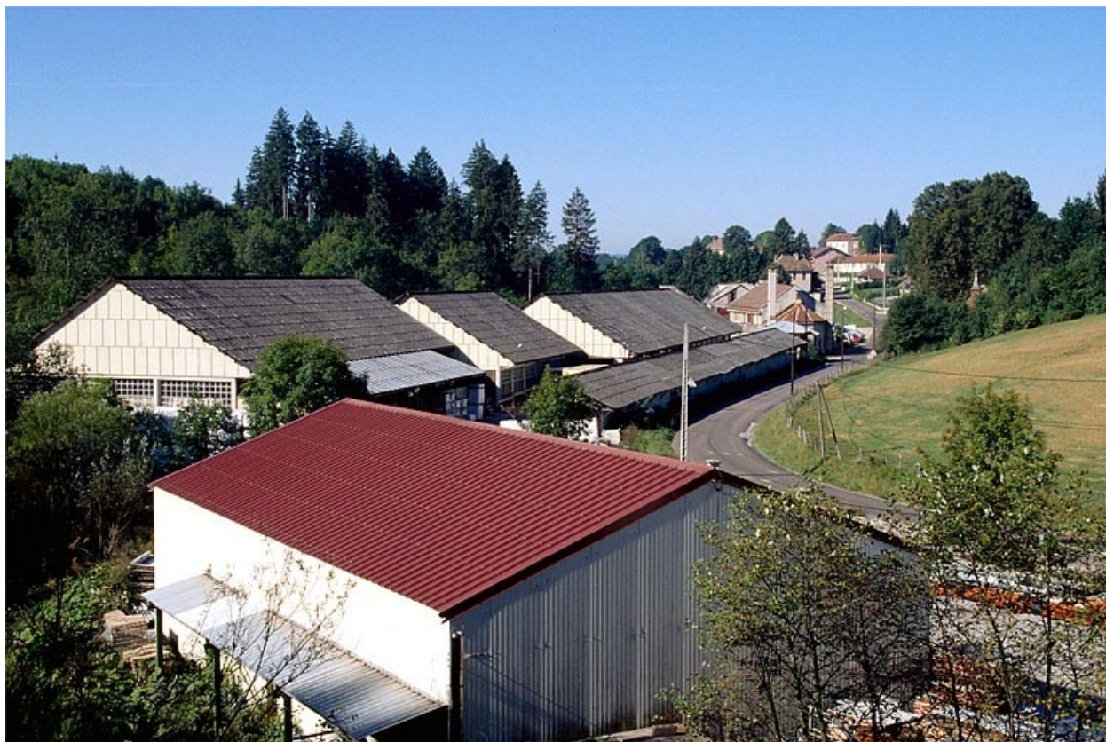
Vue d'ensemble depuis la voie ferrée.
