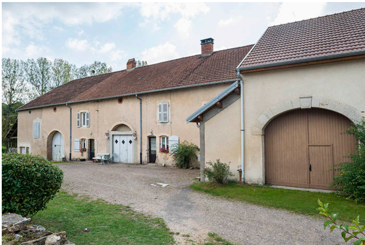
Alignement de fermes, rue de la Fontaine.
